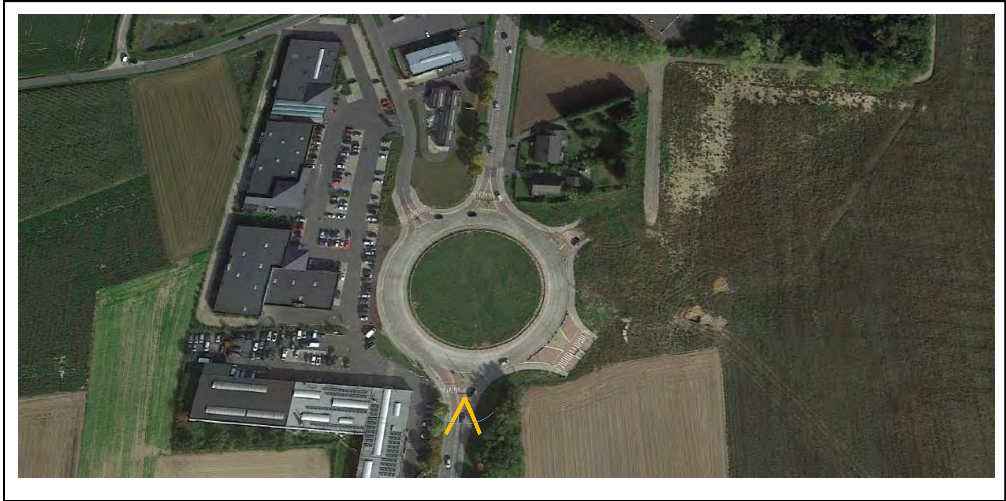
Au rond-point de la Neuve-Chaussée, vue de la chaussée vers Péruwelz.
