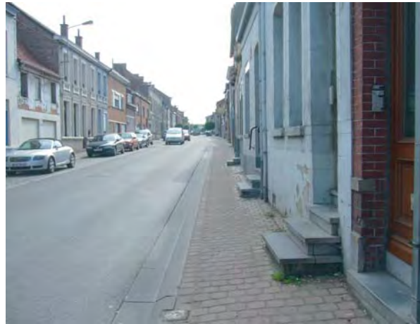
Rue de Sondeville: les escaliers menant aux habitations réduisent la taille des trottoirs
