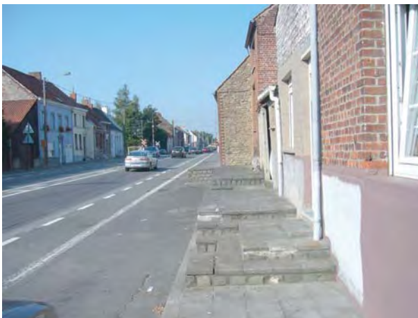
Rue Neuve Chaussée: des constructions sur le trottoir interrompent le cheminement piéton.
