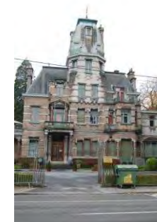
86 - maison de maître (Hôtel Baugnies - Château de La Roseraie)
