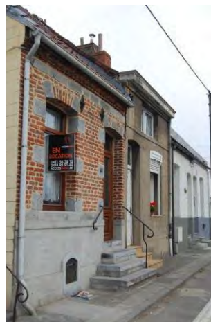
• 23 - Rue Neuve Chaussée 45 – 51 Petit alignement de maisons basses de la fin du 18 e siècle, résultant de la division tardive d'un corps unique dont subsiste le volume à pignon débordant et les travées de baies de style classique tournois au n° 45. Malgré les remaniements et les traitements différenciés en façades, ces modestes habitations préservent un rythme et une certaine cohérence.
