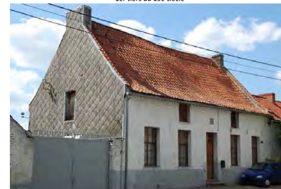
• 136 Rue de la Saulx 23 -habitation basse est datée de 1830 sur le cartouche inséré au-dessus de la porte. Construite en briques et moellons de grès, elle présente une façade blanchie traitée en double corps et bien équilibrée dans les percements à simple encadrement de briques.
