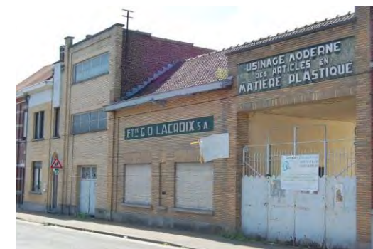
78- A proximité de la gare, cette halle du début du 20e siècle récupère l'ossature en fonte d'un ancien hangar à bois du charbonnage de Monceau-Fontaine.
