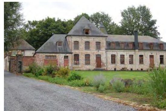
192- château (Château Marie-Louise - la Maison de Cerfontaine)- L'ancien château Marie-Louise, également dénommé autrefois La Maison de Cerfontaine, est une demeure de style classique tournaisien édifée dans la 1 re moitié du 18 e siècle. Elevé en brique et calcaire sur soubassement en moellons de grès, il a été remanié au cours des siècles suivants et est actuellement le siège d'un Institut pour jeunes.
