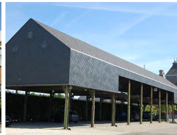
78- A proximité de la gare, cette halle du début du 20e siècle récupère l'ossature en fonte d'un ancien hangar à bois du charbonnage de Monceau-Fontaine.
