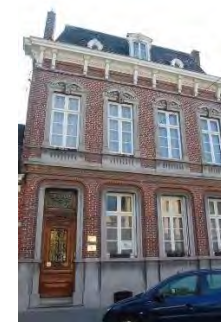
• 49 habitation - Rue Albert 1er 25 -Préservant son authenticité, intéressante maison de maître de style éclectique représentative de l'habitat urbain de la fin du 19e siècle ou du tout début du siècle suivant.
