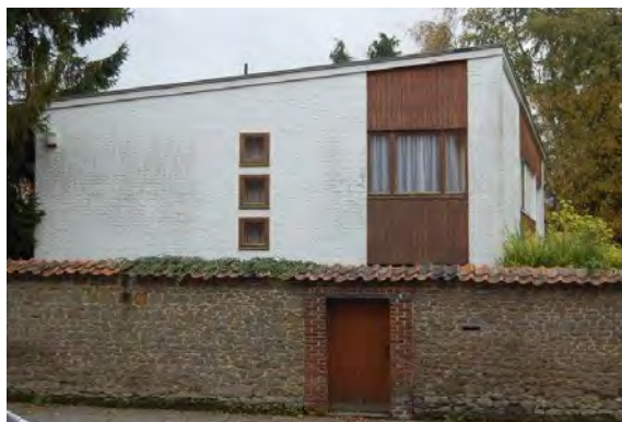
40 - Rue de la Ferté 5- Protégée par un haut mur de clôture en moellons de grès, habitation personnelle du peintre Roger Dudant construite en 1961 sur les plans de l'architecte Alphonse Pion. Inscrite dans le courant fonctionnaliste des années 1960, elle est typée par sa volumétrie, sa toiture à faible pente unique et par les façades composées selon une dominante horizontale
