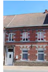
167 habitation - Rue de Sondeville 65 - habitation de style classique tournaisien remontant au milieu du 18e siècle. Façade montée sur soubassement en moellons de grès, striée de bandeaux calcaire limitant les fenêtres à encadrement alterné partiellement refait au rez-de-chaussée.
