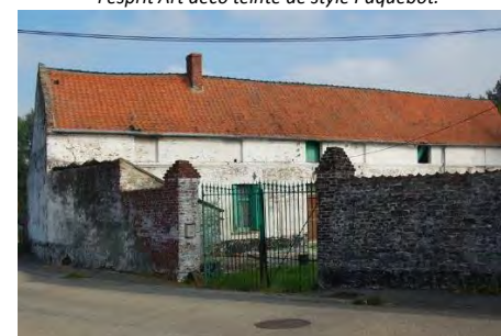
• 237 Rue Outre l'Eau 1- ancienne ferme est représentative de la typologie locale par ses volumes en brique et grès local blanchis et coiffés de tuiles rouges. Organisée en ordre lâche autour d'une cour accessible par un passage ouvert dans le mur à rue, elle est datée de 1845 au pignon de la grange en large.
