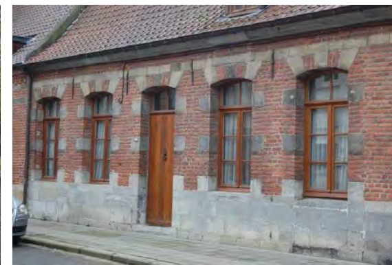
127- Rue de Roucourt 57- Ancienne maison rurale de style classique tournaisien du milieu du 18e siècle préservant les caractéristiques malgré une rénovation récente.
