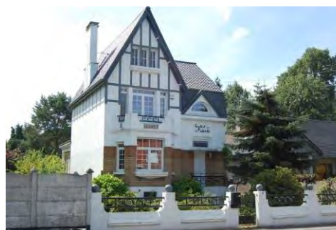
164 villa du 1er tiers du 20e siècle préserve ses caractéristiques principales malgré la perte des châssis d'origine. Dénommée "Clos Fleuri" selon une graphie typée, elle s'inscrit à la fois dans l'esprit des villégiatures par le faux colombage et les toitures débordantes, et dans le style Art déco par les matériaux utilisés, par les formes anguleuses des encadrements de baies,
