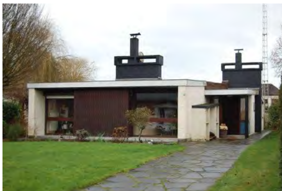
• 119- Rue du Petit Gobert 25 Habitation conçue dans la 2e moitié du 20e siècle par l'architecte Gilbert Capouillet, collaborateur d'Henri Guchez. Construite en retrait de voirie et introduite par un cheminement pavé menant sous l'auvent d'entrée, elle est caractérisée par ses fortes cheminées peintes en noir.
