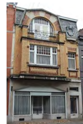
• 231 Rue Astrid 32 -Construit dans le 1 er tiers du 20 e siècle, cet immeuble de commerce et d'habitation s'inscrit dans le style Art déco pour son traitement de façade et la modénature des baies.
