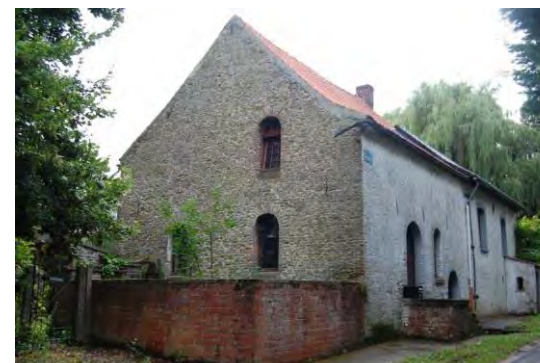
169 - moulin à eau (Moulin Sorreau - Moulin Charles-Antoine)– L'ensemble, constitué par le moulin et par les installations hydrauliques, conserve son intégrité et sa lisibilité d'usage.
