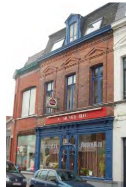
• 122 Rue Astrid 45- habitation+ magasin. Au rez-de-chaussée d'un immeuble de style éclectique du 3 e tiers du 19 e siècle, intéressante vitrine en bois peint dont la porte et les pilastres latéraux sont traités dans l'esprit néo-gothique
