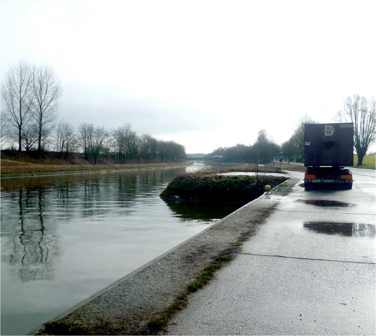
Quai Paray-Vieille-Poste (Photo JNC AWP, 2018)
