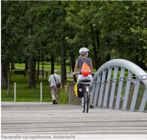
Passerelle cyclopiétonne, Anderlecht
