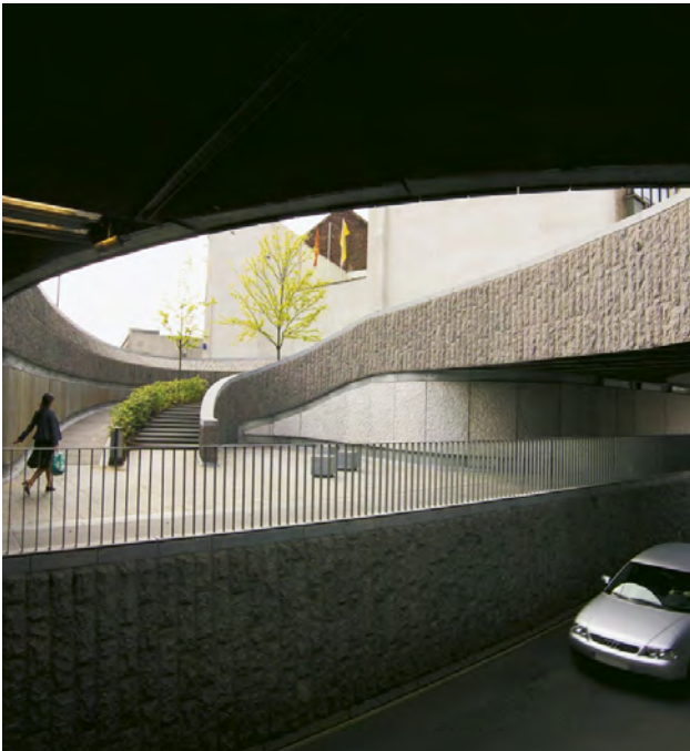
Passage sous voies multimodal, Courtrai
