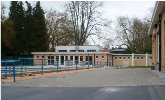
Photos de l'existant (JNC AWP)
