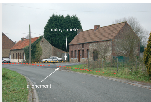
Volumes implantés sur une limite latérale, en faible recul par rapport à l'alignement.
