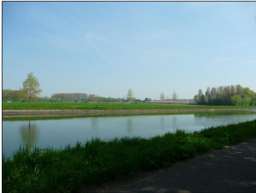
Figure 24: Photographie du canal au niveau de la rue du Fort Talon
