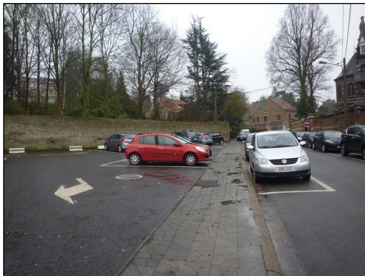
Figure 38: Photographie d'un trottoir endommagé à Péruwelz
