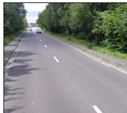
Figure 233 : Photographie de la section comprise entre la N60e et le canal
