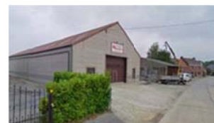
Figure 177 : Rue du Grand Tilleul
