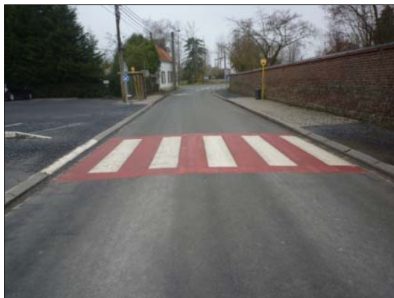
Figure 257 : Photographie, absence de dalles Podotactiles, rue de Flines à Callenelle
