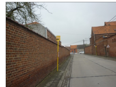
Figure 261 : Photographie, arrêt de bus sans aménagement rue Beaumont à Bury
