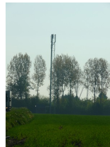
Figure 367 : Vue sur une antenne GSM
