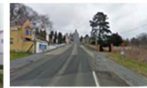
Figure 142 : Route Départementale n°935 (France)
