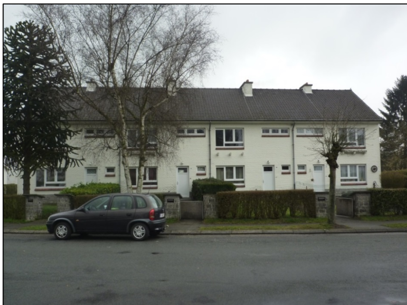
Figure 216: Photographie de maisons en bande à Péruwelz
