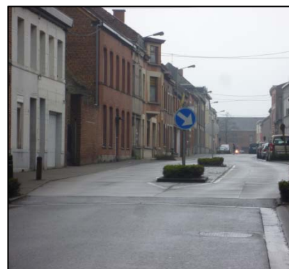
Figure 270 : Photographie, effet de porte avec dévoiement bilatéral
