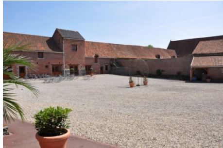
Figure 395 : Vue sur la ferme de Bouchegnies (source : www.toqueblanche.com )
