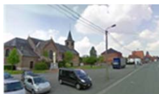
Figure 150 : Eglise de Callenelle - Rue de Tournai
