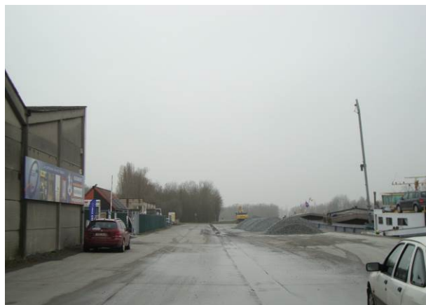
Figure 321 - Installations de l'entreprise Roucourt-Béton (3)
