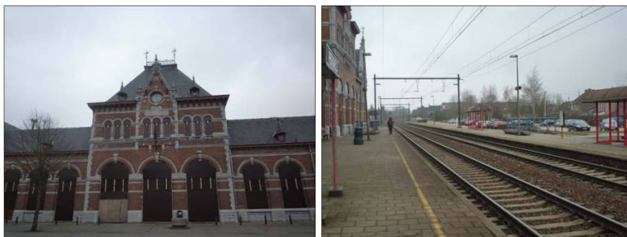
Figure 263 : Photographie, ancien bâtiment voyageurs de la gare de Péruwelz
