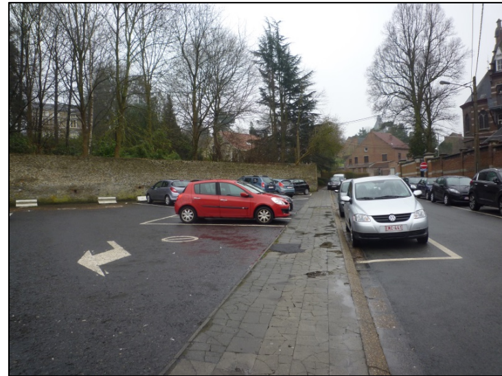
Figure 302: Photographie d'un trottoir endommagé à Péruwelz
